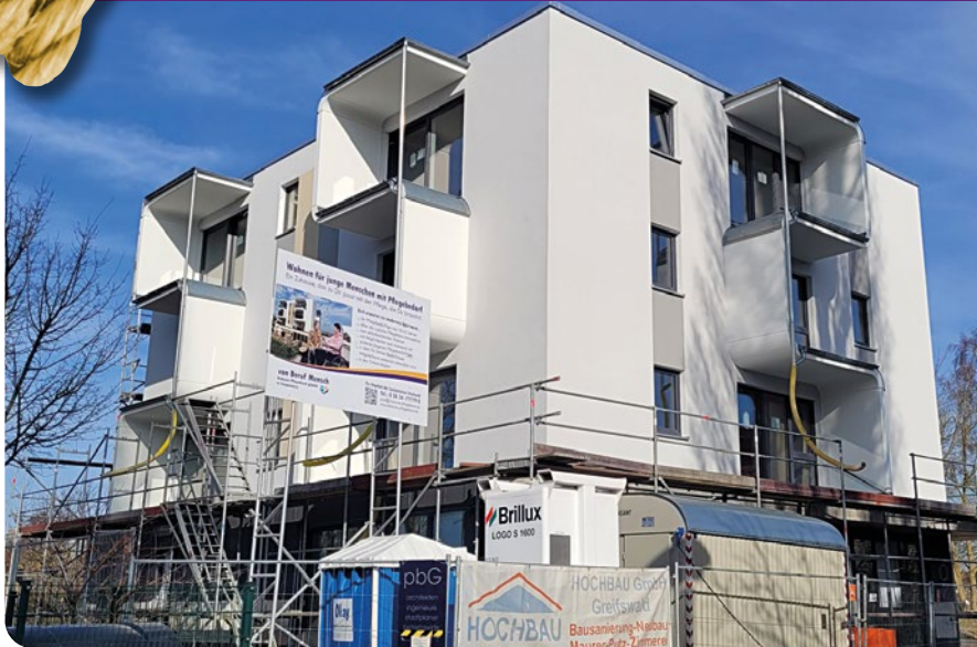
Baustelle „Junge Pflege am Sund“
